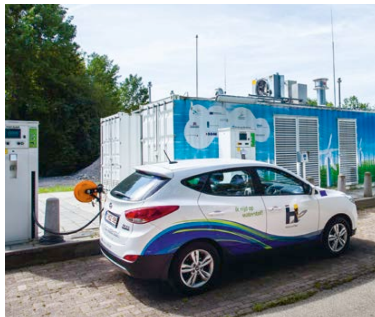
Station de recharge d'hydrogène aux Pays-Bas.
